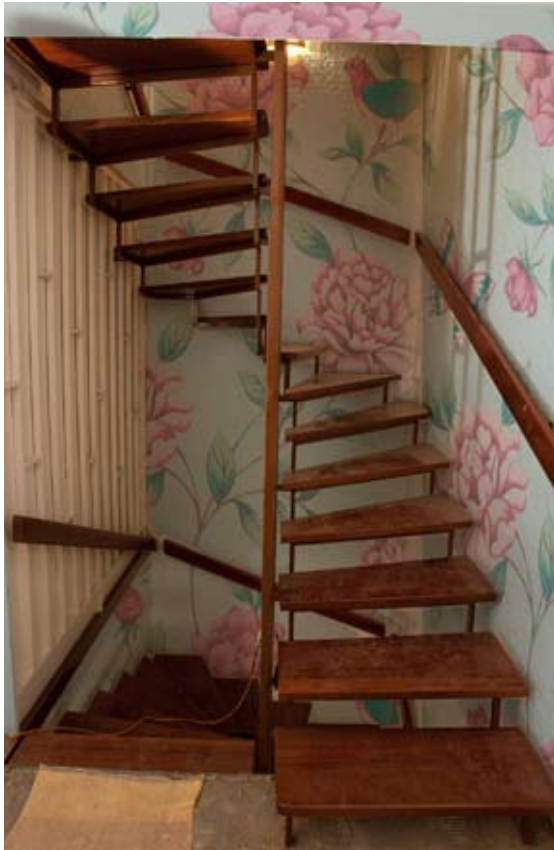
Ihre Treppenanlage im Ursprung
